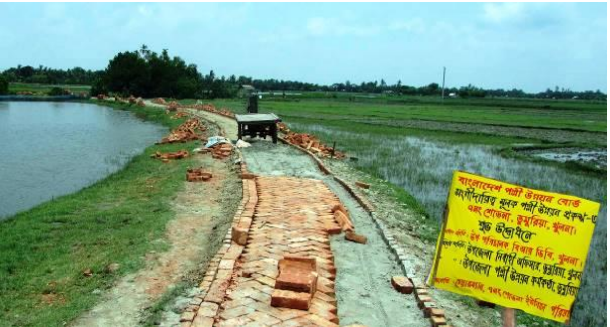
গ্রামীণ ক্ষুদ্র অবকাঠামো উন্নয়ন ও সংস্কার কার্যক্রমের আওতায় খুলনা জেলার ডুমুরিয়া উপজেলায় নির্মিত রাস্তা
