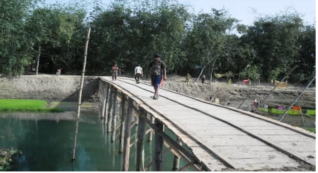
গ্রামীণ ক্ষুদ্র অবকাঠামো নির্মাণ ও সংস্কার কার্যক্রমের আওতায় কুড়িগ্রামের ফুলবাড়ী উপজেলায় নির্মিত কাঠের সেতু
